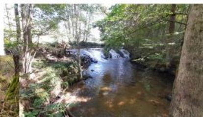
Relevé diagnostic - seuil infranchissable
