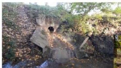
Relevé diagnostic - rejet au cours d'eau
